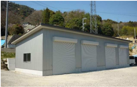
農業用倉庫の復旧状況 (呉市)
