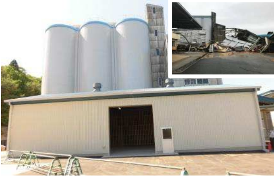
被災直後の農業用倉庫 (三原市大和町)
