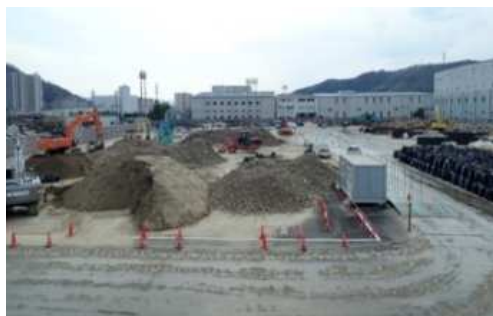
二次仮置場（坂町）処理中
